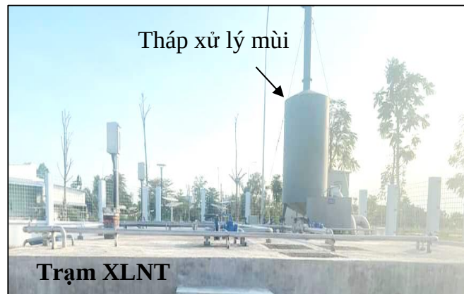
Hình 10. Hình thực tế trạm xử lý nước thải công suất 200 \text{ m}^3/\text{ngày đêm} của dự án
