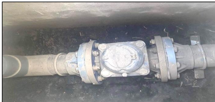
Hình 11. Hình ảnh thực tế đồng hồ đo lưu lượng nước thải đầu ra
