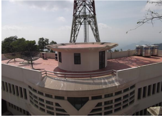
Trạm phát sóng hiện hữu
